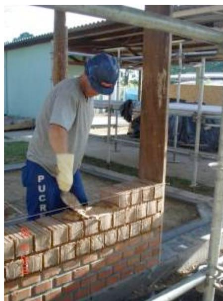
Figura 33: Canteiro Experimental – Capacitação de funcionários da Divisão de Obras da PUCRS com a técnica para o assentamento de tijolos não queimados
