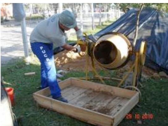
Figura 32: Canteiro Experimental – Capacitacao de funcionarios da Divisao de Obras da PUCRS com a tecnica para a producao de argamassa para o assentamento de tijolos nao queimados
