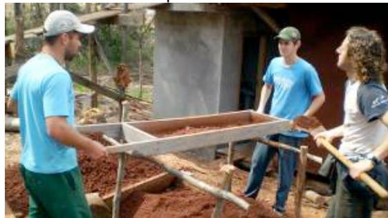
Figura 10: Processo de preparação manual. Material para a produção do reboco.
