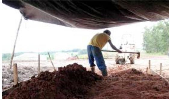
Figura 8: Processo de preparação manual. Material para a produção da tecnologia superadobe.
