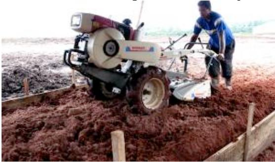
Figura 7: Processo de preparação adaptado. Material para a produção da tecnologia superadobe.
