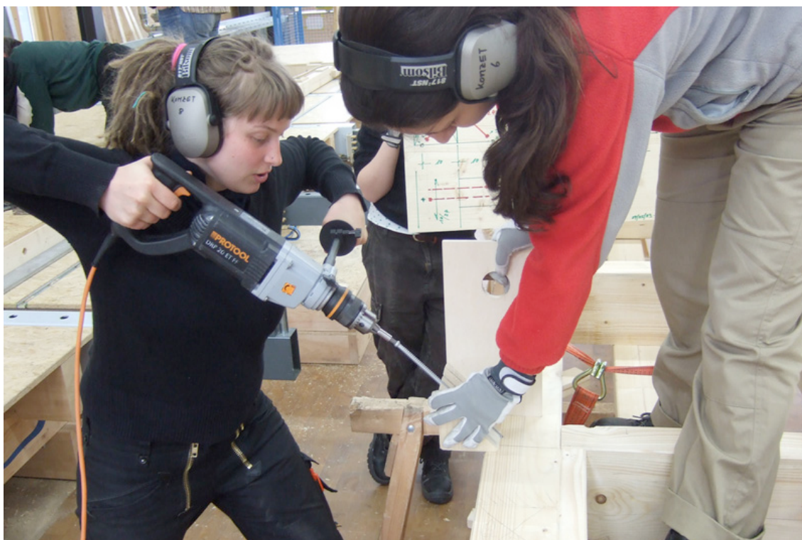
Figura 5: Construção da casa de Darmstadt para o Solar Decathlon 2009 (TECHNISCHE UNIVERSITÄT DARMSTADT, 2009)
