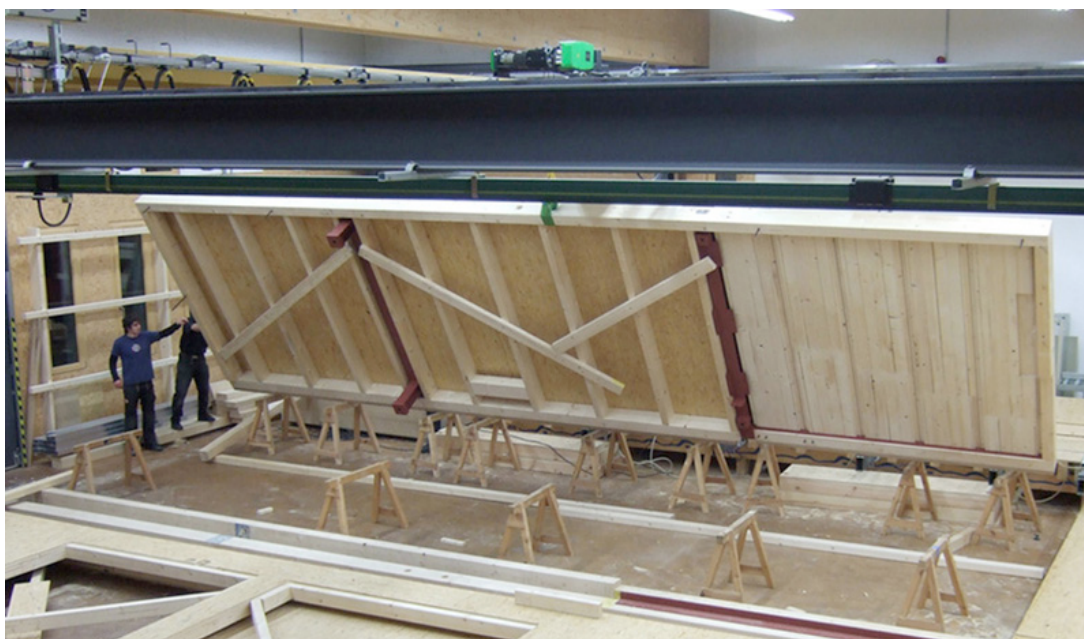
Figura 7: Construção da casa de Darmstadt para o Solar Decathlon 2009 (TECHNISCHE
