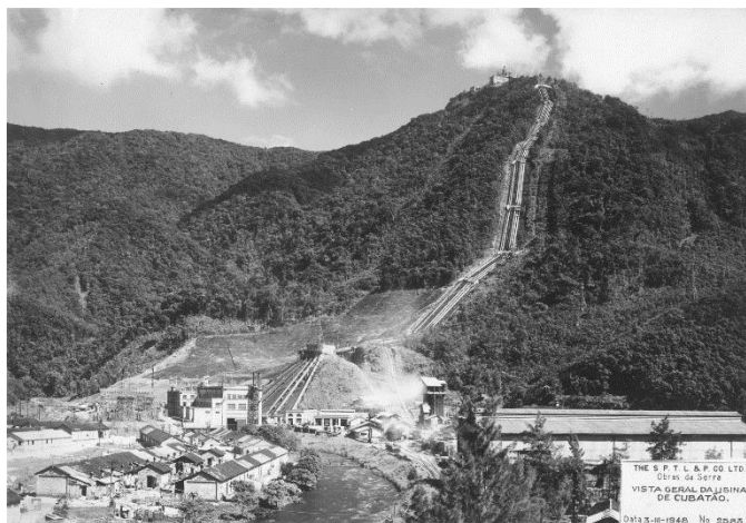
Figura 05 – Obras na serra em 1948. Fonte: Fundação Energia e Saneamento.
