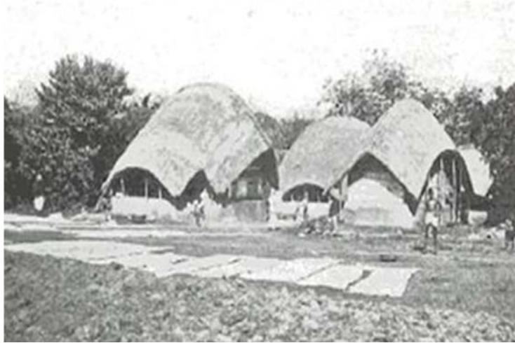
Figura 2 - Bangalôs de arquitetura vernacular indiana. Fonte: Kramer, 2006, p.10
