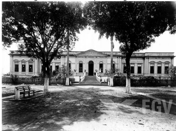
Figura 5: Fachada do Hospital Domingos Freire.
