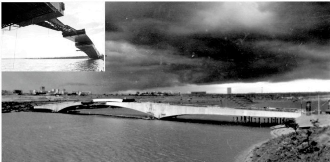
Figura 6 – Trecho em estrutura metálica da Viga Gerber, 16/01/76. Fonte: Arquivo Público do DF, 1976.
