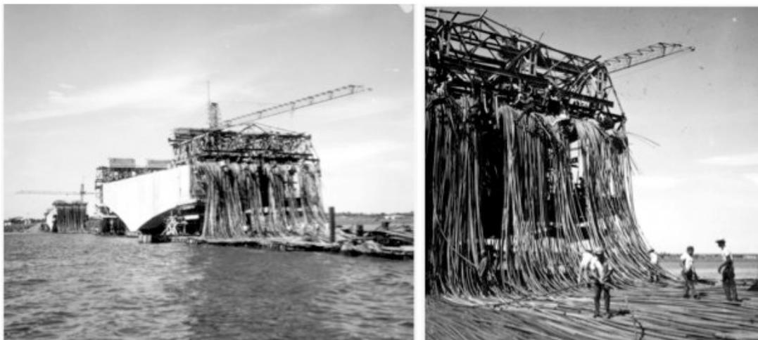
Figura 4 – Estágio da ponte quando da paralisação. Fonte: Arquivo Público do DF, 1970.
