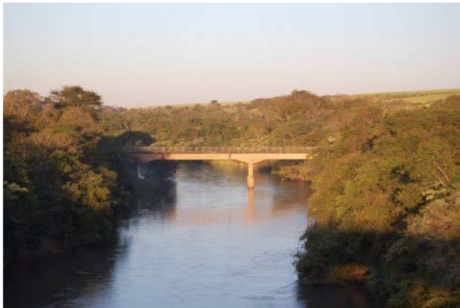
Figura 1 - Ponte sobre o Rio do Peixe, ligando os municípios de Racharia e Bastos, SP, construída em 1958. Panoramio, 2016.
