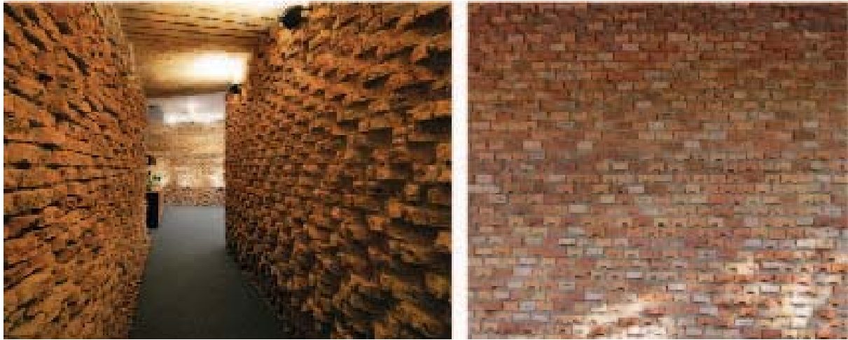
Figura 2 – Tijolo partido ao meio no corredor da sala de reuniões da diretoria na sede da Unilever Paraguai (2000-01) e nas paredes externas da Casa de Hóspedes. Fotografias (da esquerda para a direita): Enrico Cano; fotografia da autora (montagem feita pela autora).
