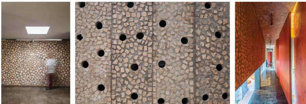
Figura 3 – Tijolo despedaçado agregado ao concreto nas paredes da Fundação Teletón Paraguai (2008-10), nos painéis pré-fabricados das residências RP (2008) e Verônica (2012). Fotografias (da esquerda para a direita): Lauro Rocha; Leonardo Finotti; Lauro Rocha (montagem feita pela autora).
