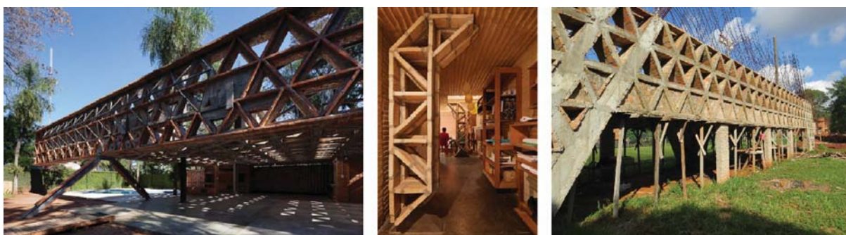
Figura 8 – Viga do Quincho Tia Coral (2015), pilares do subsolo da residência Abu & Font (2004-06) e vigas, pilares e lajes do aulário da FADA-UNA, em construção. Fotografias (da esquerda para a direita): Federico Cairoli; Federico Cairoli; fotografia da autora (montagem feita pela autora).
