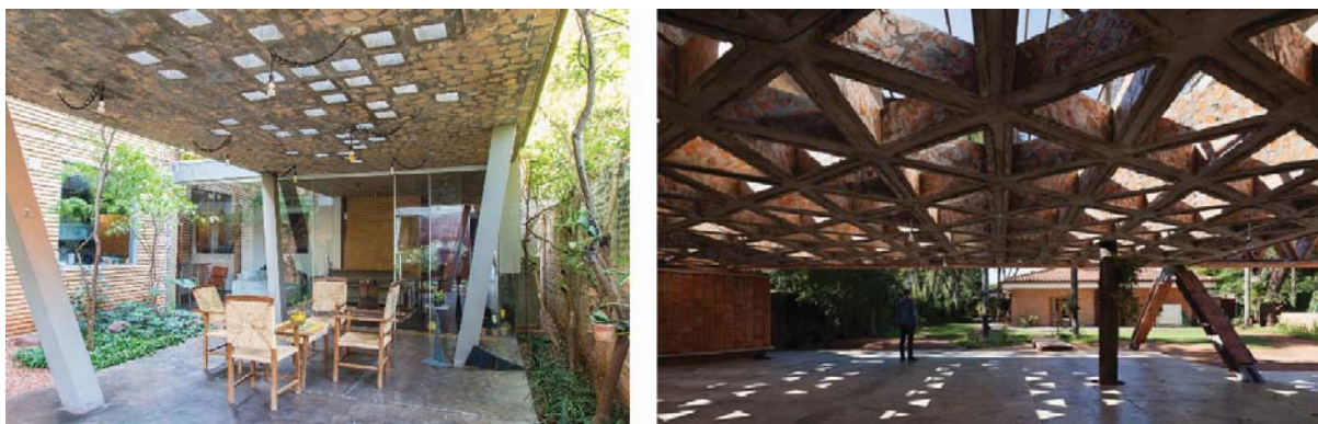
Figura 7 – Lajes que cobrem o pátio da residência Verônica (2012) e o Quincho Tia Coral (2015). Fotografias (da esquerda para a direita): Federico Cairoli; Lauro Rocha; Federico Cairoli (montagem feita pela autora).
