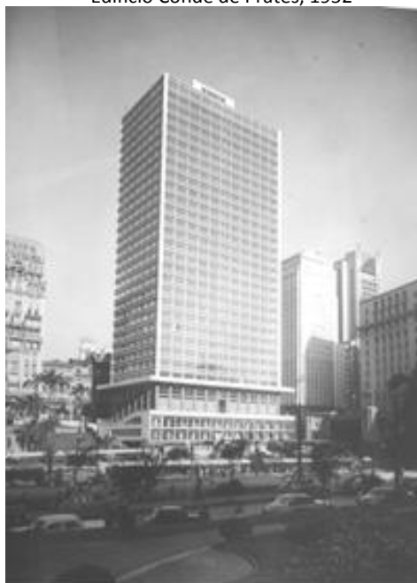
Edifício Conde de Prates, 1952
